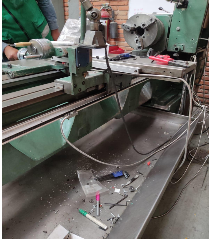
Imagen 2.3.-Instalación de encoder lineal eje Z
