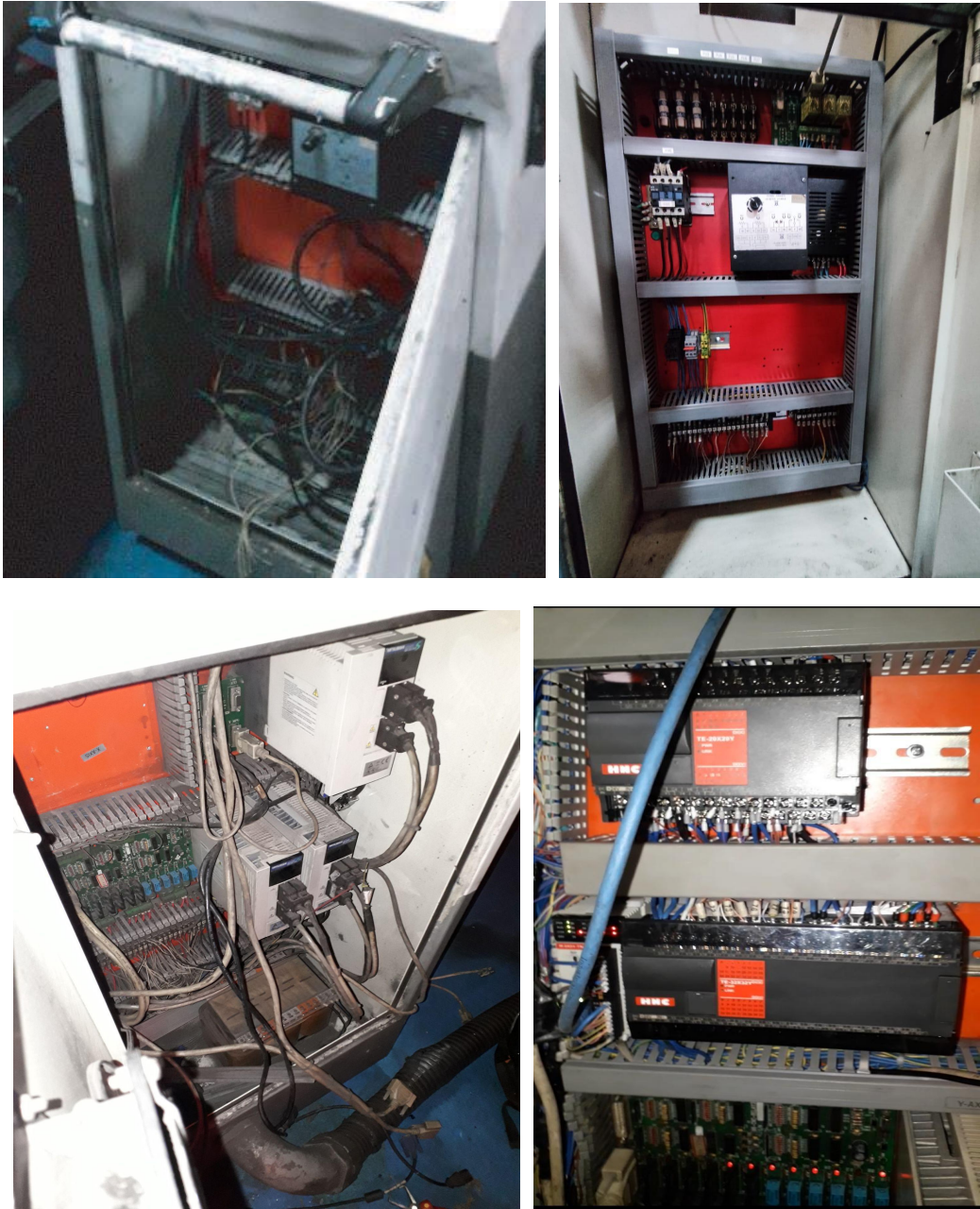
Imagen 2.5.- Antes y después de tableros de control
