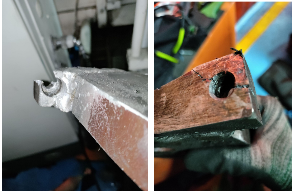
Imagen 2.4.- Inspección visual de componentes mecánicos
