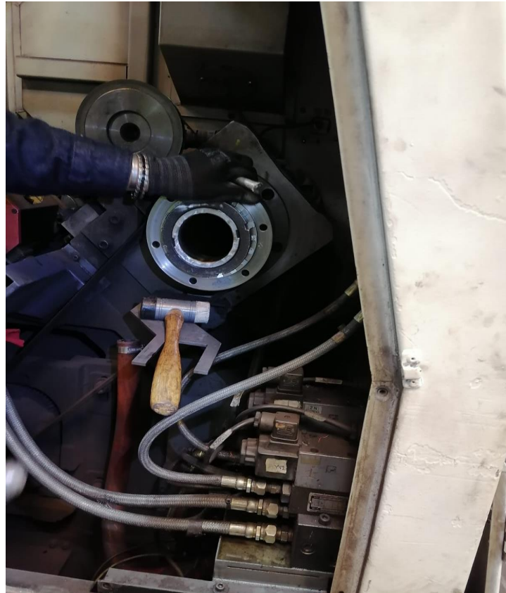
Imagen 1.0 Electroválvulas de control
